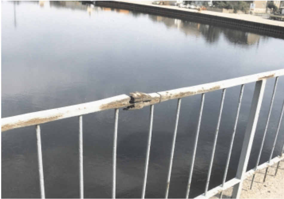
Bild 2.8: Geländerschaden
