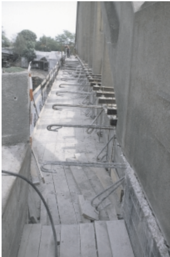
Bild 2.10: Entfernte Gehwegkonsolen, alte Bewehrung
