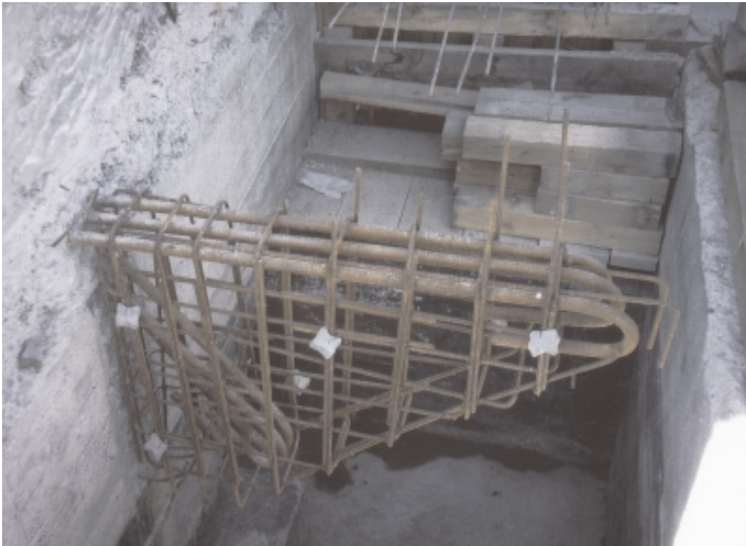
Bild 2.12: Ergänzung der Bewehrung für neue Gehwegkonsolen
