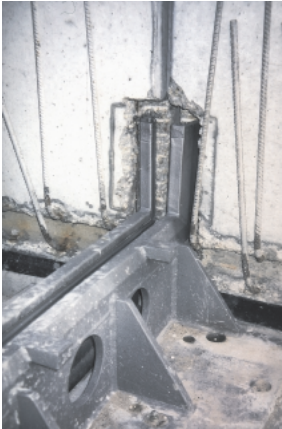
Bild 2.13: Fahrbahnübergang Übe 1 Gehwegbereich mit Anschluß an Rüstung
