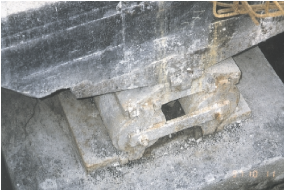
Bild 2.7: Funktionsfähiges Rollenlager Stromüberbau, Seite Alsleben
