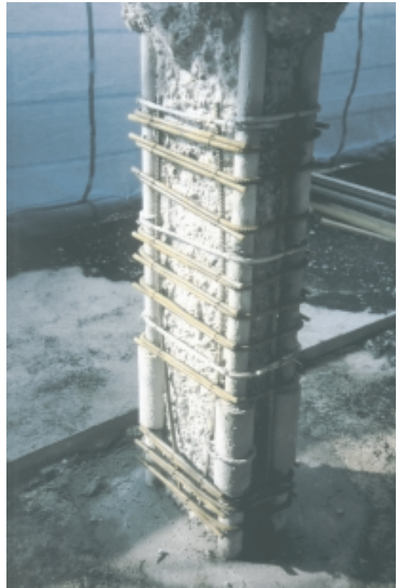
Bild 2.11: Freigelegte Bewehrung für neue Gehwegkonsolen
